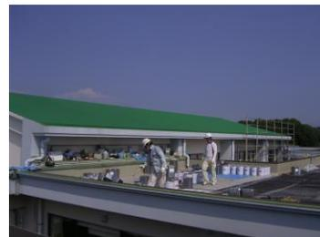
傾斜のある屋根のため補修の全てが手作業であり、炎天下の中での作業となった。
